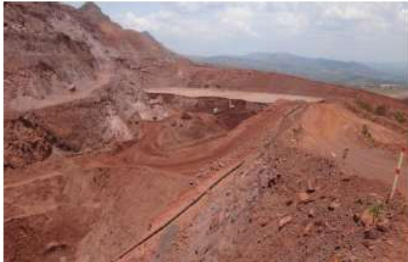
Figura 46: Enchimento da cava exaurida com os rejeitos da mineração. Fonte: Belo Horizonte, 2016.
