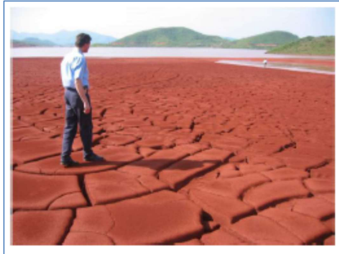
Figura 57: Superfície compactada da disposição de rejeitos espessados. Fonte: Guimarães, 2011.
