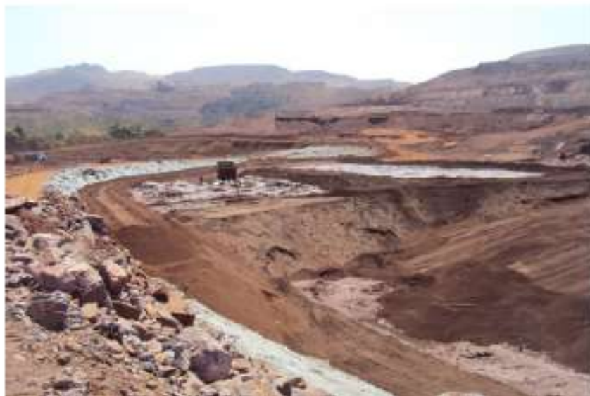
Figura 47: Empilhamento drenado dos rejeitos. Fonte: Belo Horizonte, 2016.
